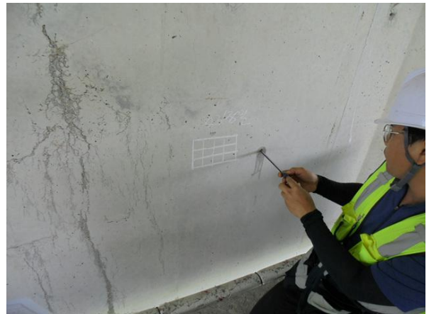
탄산화 깊이 측정
